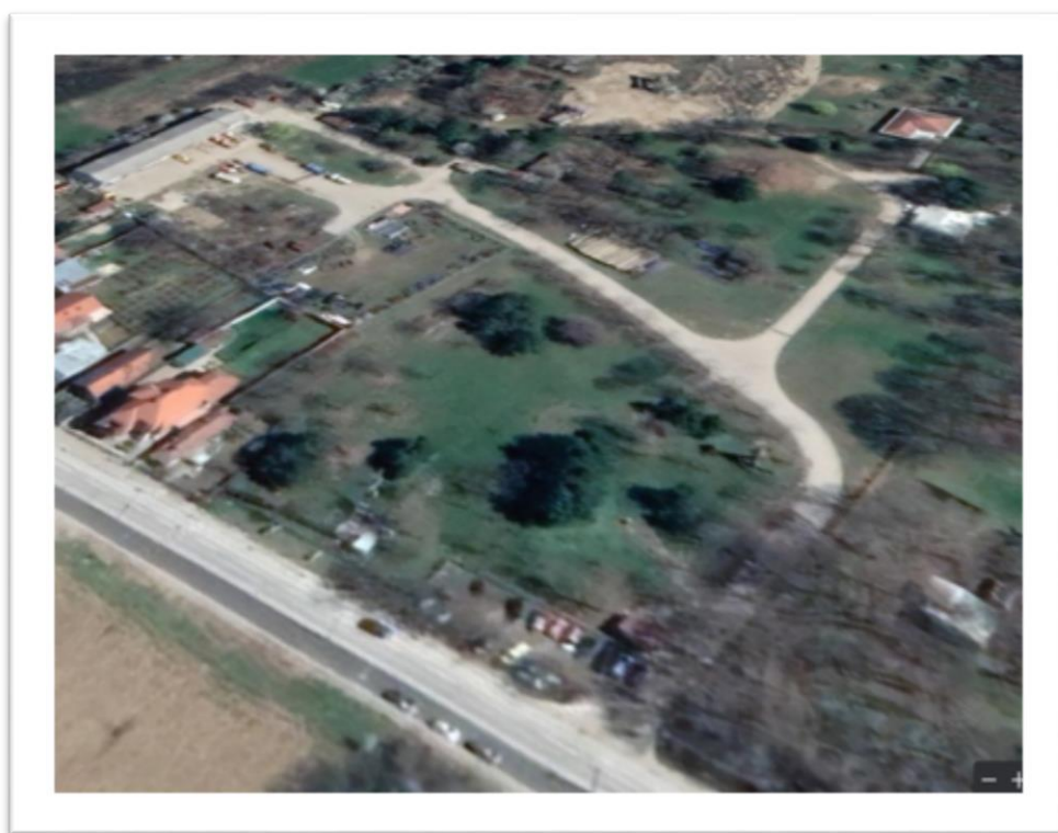
Слика 8. Старо постројење, ул. Влајкова 197, Лесковац
